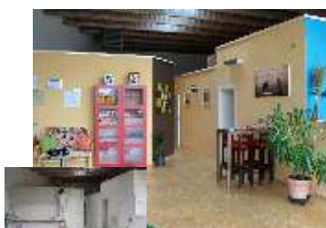
Diese Praxisräume wurden komplett im MAGU IN System erstellt, Auf die Behandlungszimmer wurde eine Holzbalkendecke als Raumabschluss gelegt - die Holzbalken wurden einfach in die MAGU IN Wand eingeschnitten.
